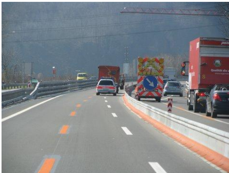
Fig. 1 : Ligne de guidage jaune orangé sur un dispositif de séparation mobile
